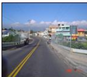
Uno de los puentes recuperados
