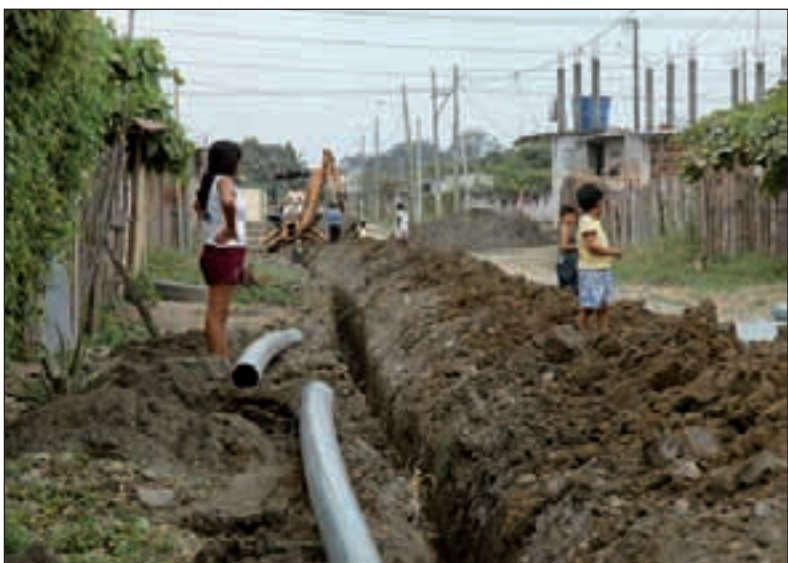
Las obras de agua potable y canalización permiten mejorar la calidad de vida de la población
