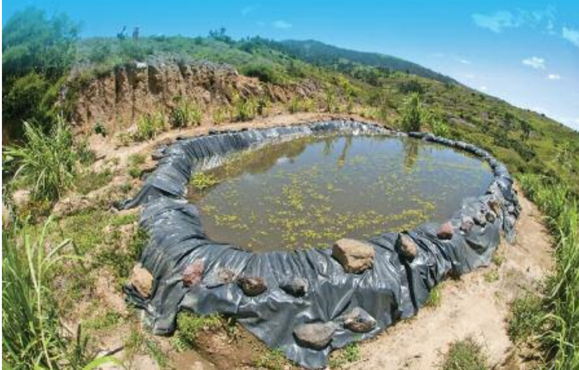
Piscina recolectora de agua lluvia
