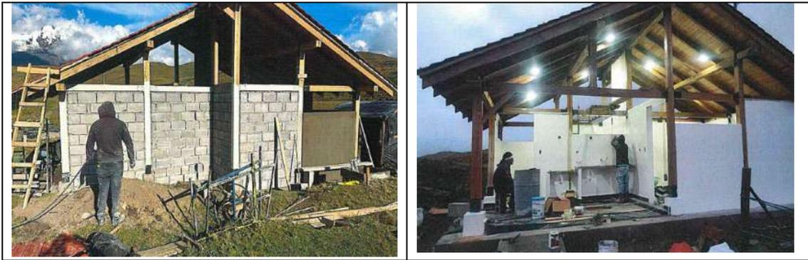
Figura 93 Armado de mampostería, colocación de techo, enlucido y prueba eléctrica.
