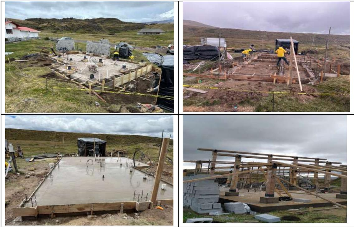
Figura 92 Fundición de losa de contrapiso y armado de columnas y vigas de madera colorado.
