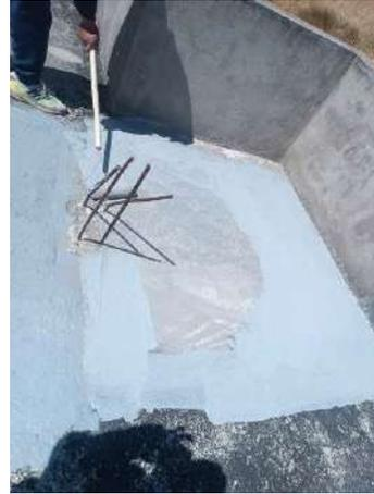
Figura 101 Impermeabilización de la terraza de la casa de Espejo.
