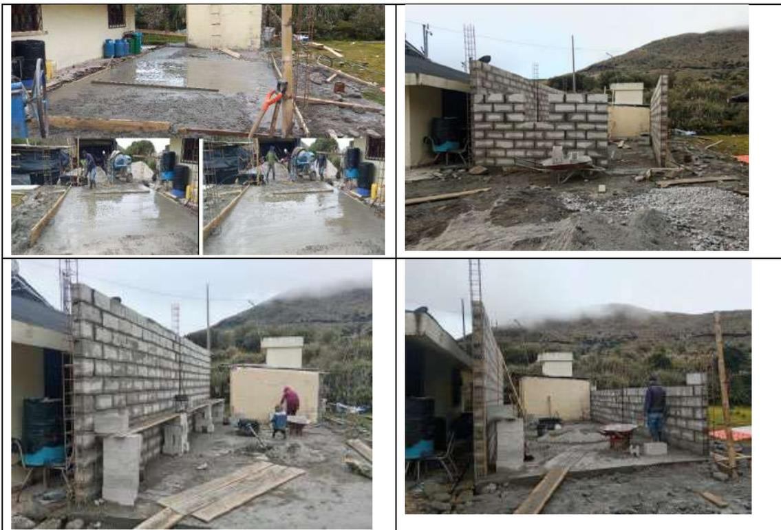
Figura 97 Nivelación del terraplén, fundición de cimientos y mampostería.
