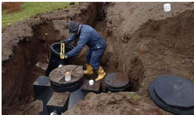
Figura 89 Implementación del sistema de saneamiento en el campamento del área de Conservación Hídrica de Alto Pita.
