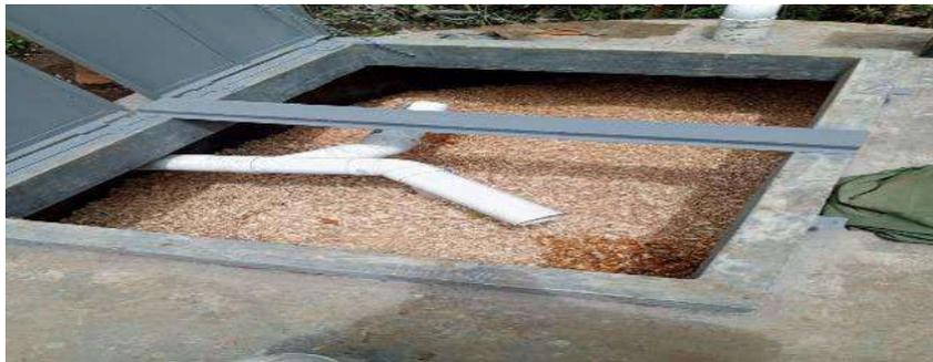
*Figura 164 Implementación de dos sistemas de saneamiento (vermifiltro), para gestionar de manera adecuada las aguas residuales domesticas*
