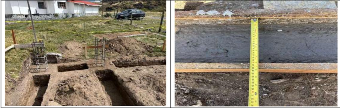
Figura 91 Excavación de suelo natural, en plintos cadenas, igualando el piso y Fundición de replantillo de los plintos.
