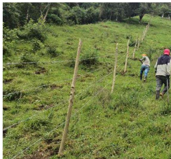
Figura 127 Instalación de cercado.
