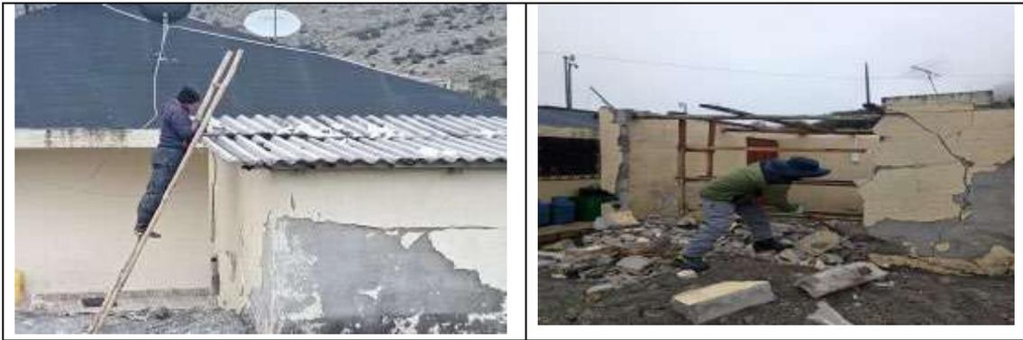
Figura 96 Desmontaje de cubierta y derrocamiento de paredes.
