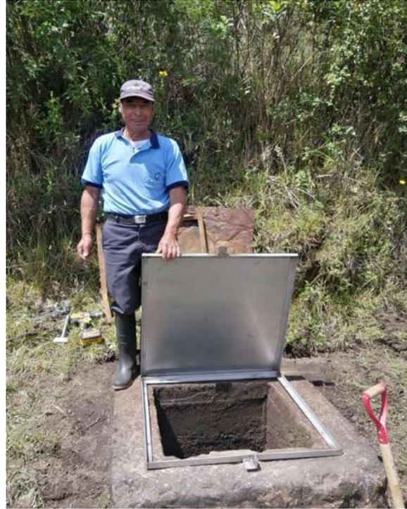
Figura 106 Cambio de tapas de protección de los tanques. Abajo, tapas de Acero INOX304
