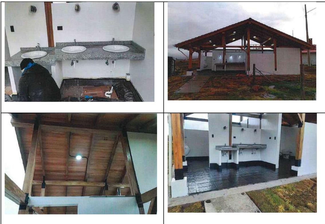
Figura 94 Armado de mesones, lavamanos, vereda principal, instalación tubo conduit y piedra en el piso.
