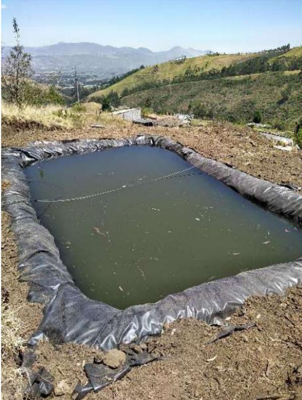
*Figura 181 Revestimiento del reservorio con geomembrana y entrega de materiales de ferretería para la construcción de hospedajes para aves en la comunidad de San Rafael.*
