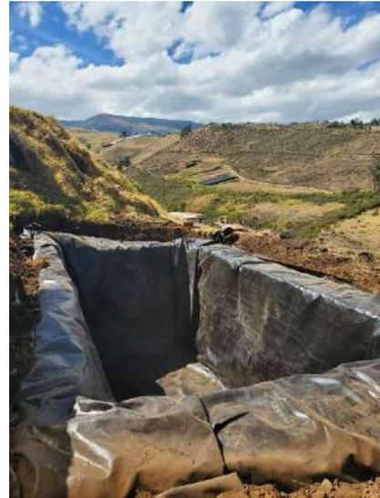
Figura 158 Revestimiento de 3 micro-reservorios con geomembrana en 3 predios diferentes de la comunidad de Aglla
