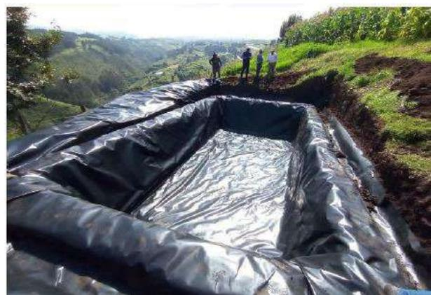
*Figura 157 Revestimiento de 9 micro-reservorios con geomembrana en 9 predios diferentes de la comunidad de Aglla*
