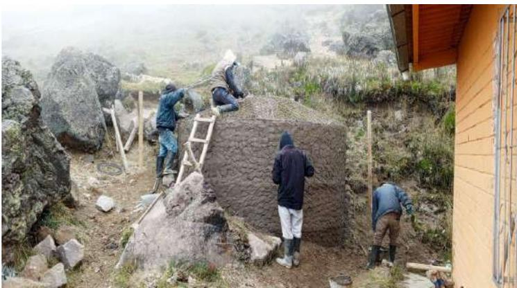
*Figura 171 Adecuación del tanque de recolección de agua lluvia*
