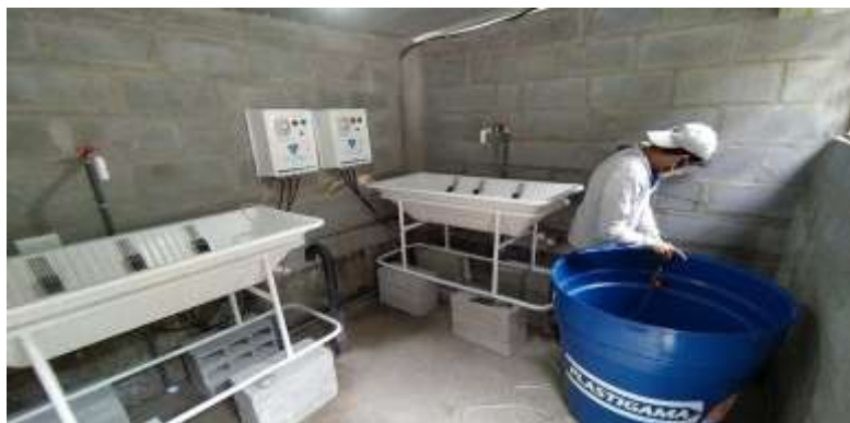
Equipo de cloración en GAD Papallacta
