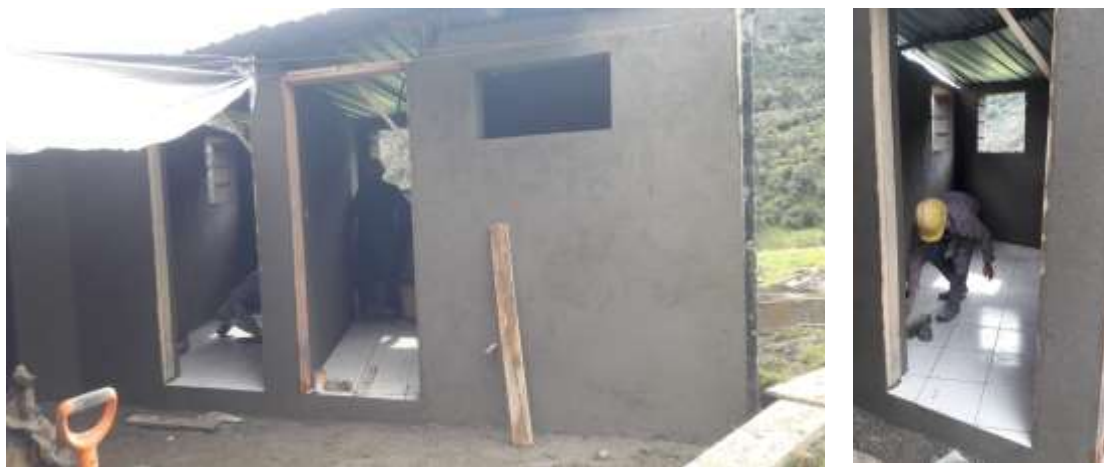
Avance de la obra de construcción
