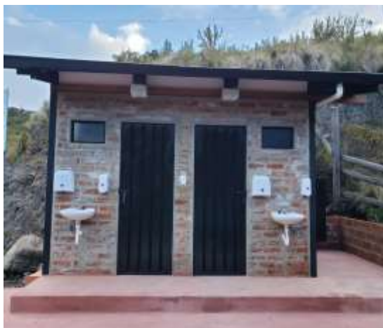
Baterías sanitarias en Paluguillo
