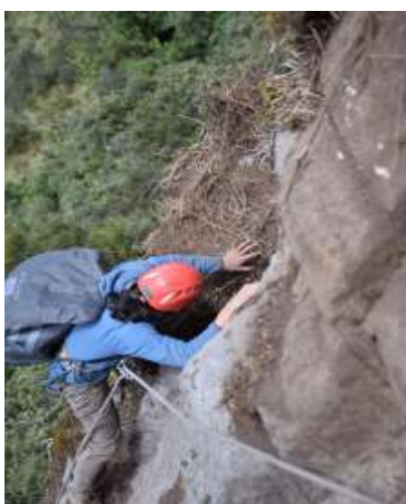
Limpeza de las rocas
